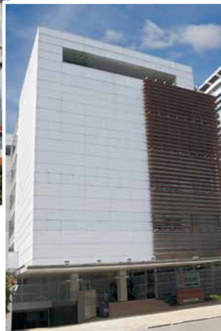
Nome da Obra: Laboratório Fleury Ano da Obra: 2007 Cidade: São Paulo - SP Cliente: Enal
