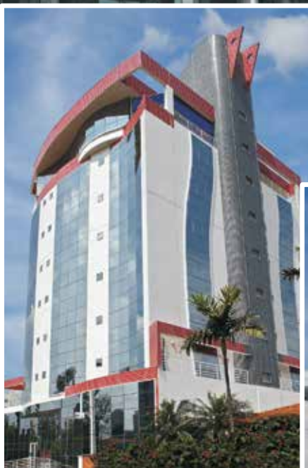
Nome da Obra: Edifício Lúmen Ano da Obra: 2009/ 2010 Cidade: Campinas - SP Cliente: Alquali
